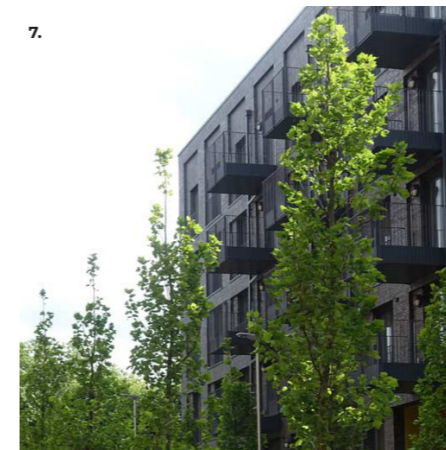
Ulokeparvekkeet ja parveke-elementit puiston puolella
